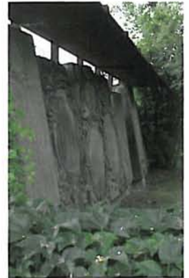
Abb. 7: Moderne Überdachungen für historische Grabplatten
